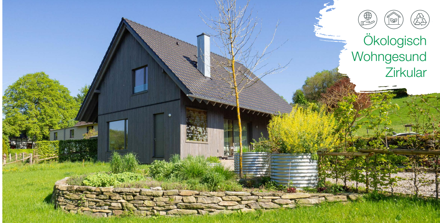
Einfamilienhaus in der Eifel, Holzständerbauweise mit esb-Plus Holzbauplatten und ClayTec Lehmputz im Innenausbau, Ausführung Zimmerei Krings Reinke
