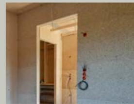
1 Aufbau in Holzrahmenbauweise, Innenbeplankung der Wände mit esb-Plus Holzbauplatten
