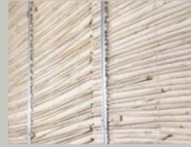
2 Anbringen von Rohrgewebe St 70 als Putzträger direkt auf die esb-Plus Platten
