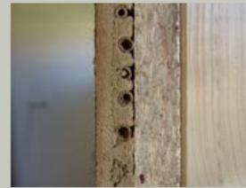
Das Rohrgewebe haftet durch die Klammern an der esb-Plus Holzbauplatte, der Putzaufbau haftet am Rohrgewebe
