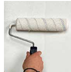
Lehmfarbe aufgetragen mit Rolle
