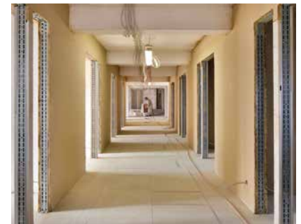
Lehm-Dünnlagen Beschichtung beim BV UN-Campus, Bonn
