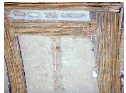
Rohrgewebe St70 auf Holzbalken einer Fachwerkwand
