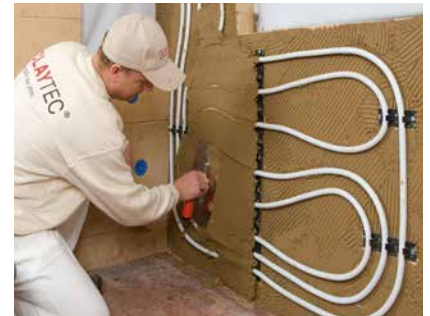
Der Unterputz wird über die Rohrscheitel abgezogen
