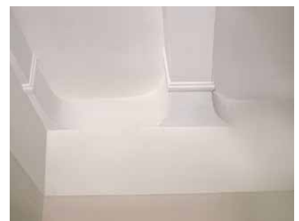
Decke mit umputzten Balken, ausgerundeten Kehlen und Stuckprofilen
