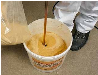
Einrühren des Eimerinhalts in Wasser. Danach 30 Minuten quellen lassen.
