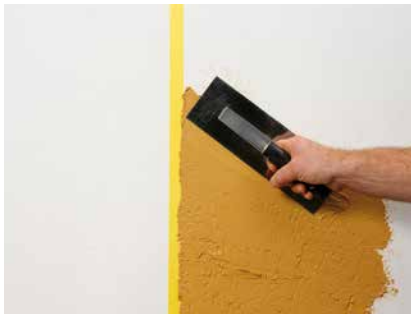
Auftrag der ersten Farbe an das Klebeband
