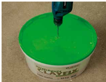
Bei geschlossenem Deckel einmischen
