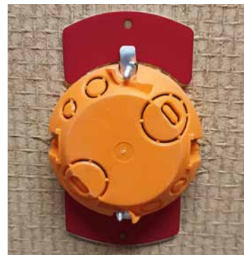
Hollewandoos gemonteerd, plaat achterzijde
