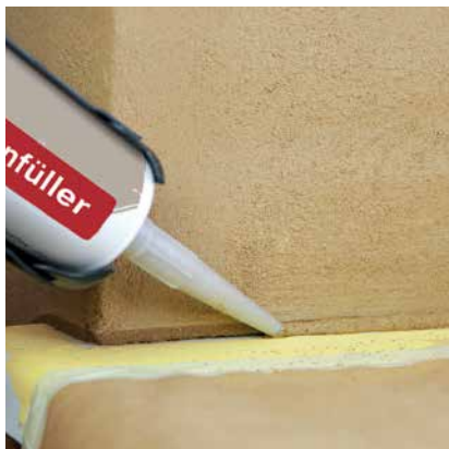
Fugenfüllung mit natur-braun an einer Fensterbank
