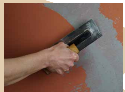
Auftrag der marmorierten Decklage
