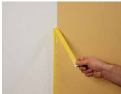
Abziehen nach dem Abwischen
