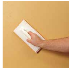
Eerste wrijving van het oppervlak.
