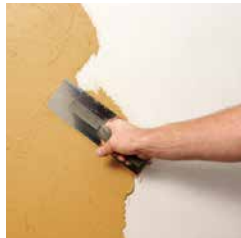
YOSIMA wordt met de spaan en troffel aangebracht.
