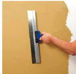
Effenen van spaan- of troffelaanzetten met de oppervlakfinish
