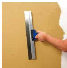
Lissage des raccords de truelle avec la taloche de surface.
