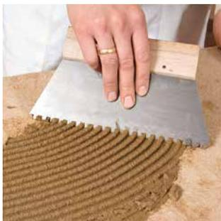
L'application du mortier d'adhérence au moyen d'un peigne à dents garantit une épaisseur homogène. L'armature tissée est ensuite posée et intégrée. Cette opération peut être réalisée sans problèmes par le constructeur de l'ossature en bois.
