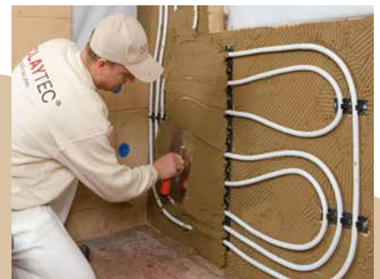
De basispleister wordt over de buisopzetstukken getrokken.
