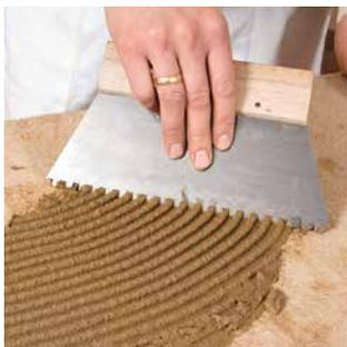
Der Materialauftrag von Lehmklebe- und Armiermörtel mit dem Zahnpachtel gewährleistet die gleichmäßige Dicke. Das Bewehrungsgewebe wird dann nur noch aufgelegt und eingebettet. Dieser Arbeitsgang kann sehr gut auch vom Holzbauer ausgeführt werden.
