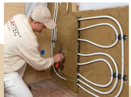
Der Unterputz wird über die Rohrscheitel abgezogen
