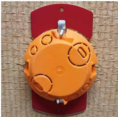
Hohlwanddose montiert, Plattenrückseite
