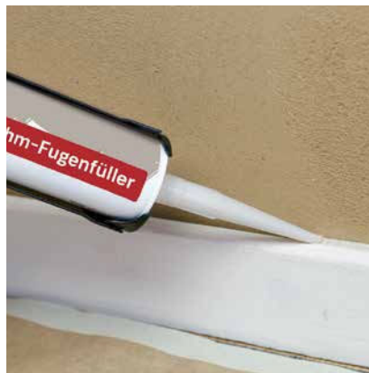
Fugenfüllung mit natur-weiß an einer Sockelleiste
