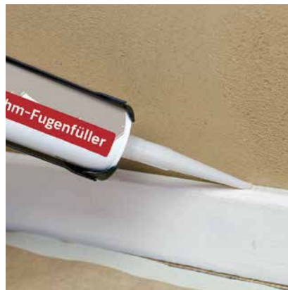
Fugenfüllung mit natur-weiß an einer Sockelleiste
