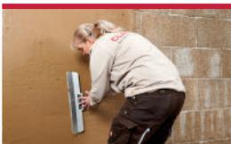
Nachdem der Putz aufgetragen wurde, muss er mit einem breiten Flächenspachtel grob abgezogen werden. Alternativ kann eine Kartätsche verwendet werden. Lehmputze sind übrigens wasserlöslich. Das heißt, heruntergefallenes Material kann ganz einfach aufgesammelt und Wiederverwendet werden. Außerdem bleibt Lehmputz abgedeckt über mehrere Tage verarbeitungsfähig.
