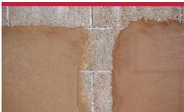
Wenn der Putz durchgetrocknet ist, kann die weitere Bearbeitung erfolgen. Es gibt eine einfache Möglichkeit, um die Trocknung festzustellen: je trockener der Putz ist, desto heller wird er. Wenn die Wand nicht mehr heller wird, kann die Weiterbearbeitung beginnen.
