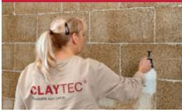
Die Flächen müssen frostfrei, trocken und sauber sein. Zunächst sollte die Wand mit einem weichen Besen abgefegt werden, um Schmutz und Staub vollständig zu entfernen. Zur Bindung von Staubresten kann die Wand per Sprühnebel vorgeneßt werden.
