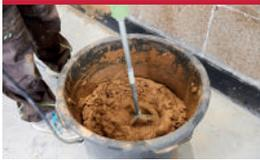
Löcher und Unregelmäßigkeiten können einfach mit Lehmputz zugeworfen werden. Die Ausbesserungen müssen vor dem eigentlichen Putzauftrag trocknen.
