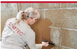
Im Anschluss kann der Lehmputz großflächig aufgetragen werden. Der Lehmputz kann mit einer japanischen Unterputzkelle aufgezogen werden.
