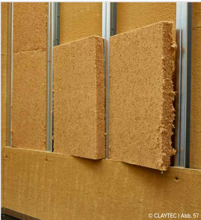
Dämmung Holzweichfaser
