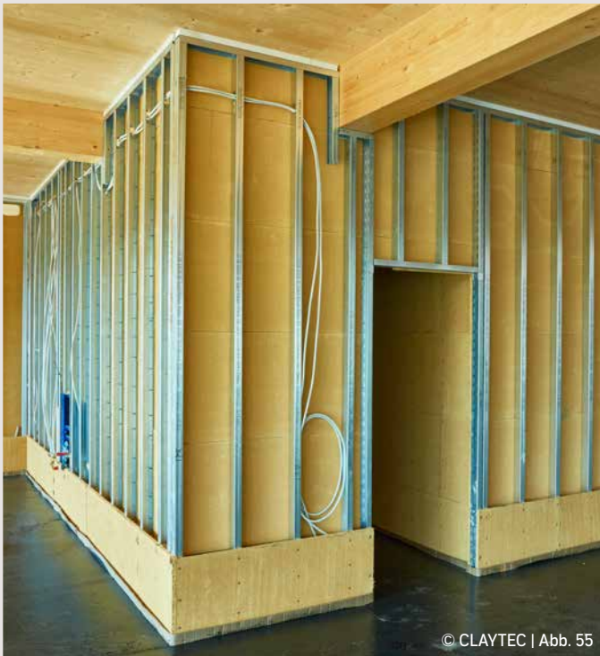
Konstruktion Metallprofile mit Lehmbauplatten
