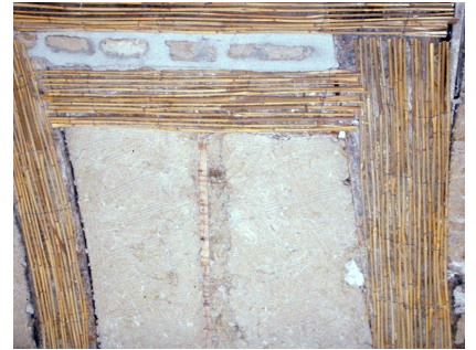
Rohrgewebe St70 auf Holzbalken einer Fachwerkwand
