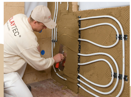
Der Unterputz wird über die Rohrscheitel abgezogen
