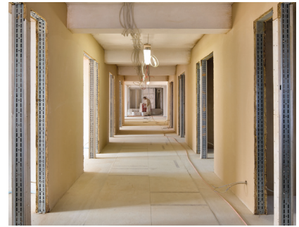
Lehm-Dünnlagen Beschichtung beim BV UN-Campus, Bonn
