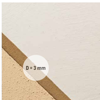
Beispiel mit ClayFix Lehm-Anstrich System
