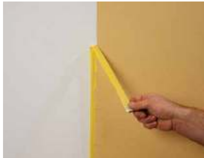
Abziehen nach dem Abwischen
