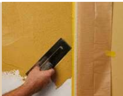
Auftrag der zweiten Farbe
