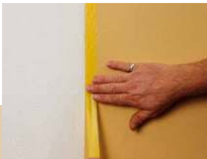
Erneutes Abkleben nach Trocknung
