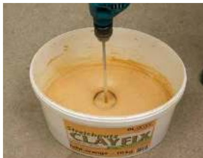
Nach 30 Minuten Quellzeit gut durchrühren
