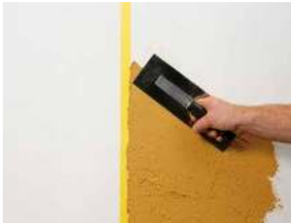
Auftrag der ersten Farbe an das Klebeband
