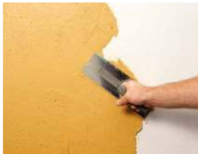
Aufziehen mit dem Glätter
