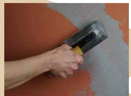
Auftrag der marmorierten Decklage
