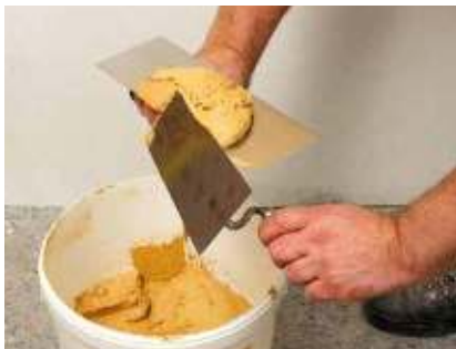
Entnehmen des Mörtels
