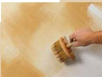
Auftrag der zweiten Farbe
