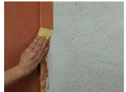
Abziehen scharfer Winkel
