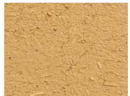
Struktur einer gut vorbereiteten Fläche aus Lehm-Unterputz
