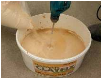
Einrühren des Eimerinhalts in Wasser
