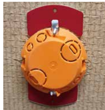
Hollewandoos gemonteerd, plaat achterzijde
