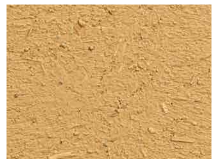
Struktur einer gut vorbereiteten Fläche aus Lehm-Unterputz
