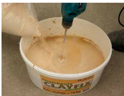
Einrühren des Eimerinhalts in Wasser
